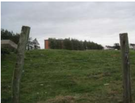
Vue de la digue de 1925 qui est un point de rupture avec derrière la résidence précitée.
