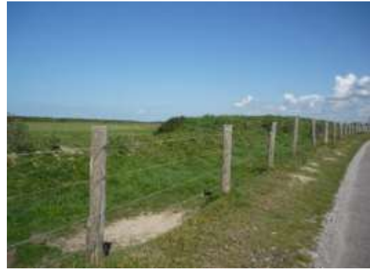
Irrégularités dans la digue Taaf à proximité du quartier des Écardines – 2015
