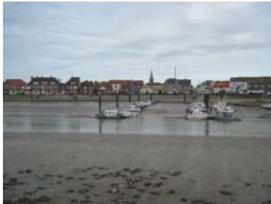
Vue de l'autre berge sur la commune de Gravelines et on constate que celle-ci est plus haute que celle qui borde la place aux Espagnols à Grand-Fort-Philippe.
